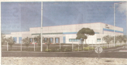
Le nouveau bâtiment devrait être réalisé en 2011. Photo Caroine Morel et Républic technologie
